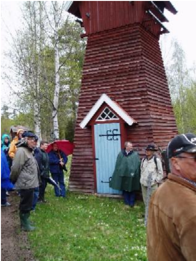
Ett transformatorhus i Närsen beskådas
